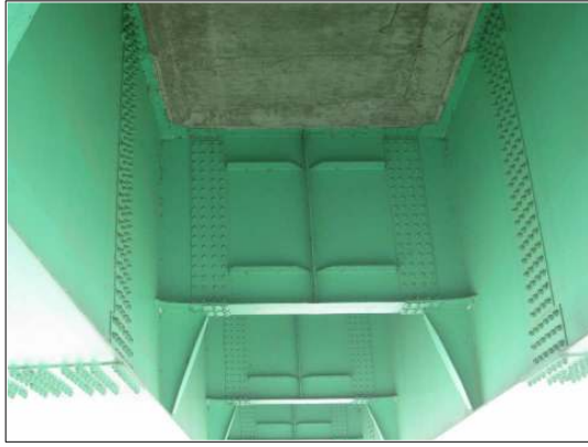
a. 가로보(원주방향) 전경
