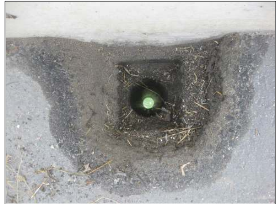
b. S 17 (양평방향) 그레이팅 유실
