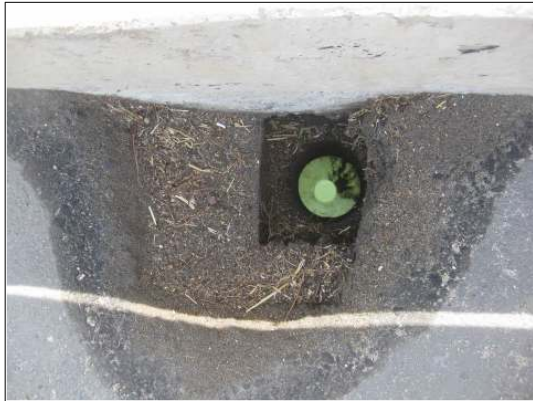
a. S 6 (양평방향) 그레이팅 유실
